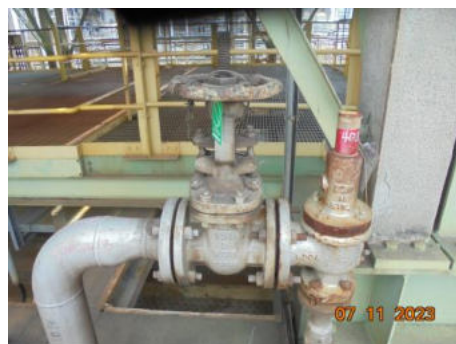
ภาพที่ 2.2-42 วาล์วระบายความดัน (Pressure Relief Valve)
