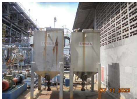
ภาพที่ 2.2-17 Slop Oil Tank เพื่อรวมคราบน้ำมัน จากบ่อพักน้ำเสีย CPI/IAF
