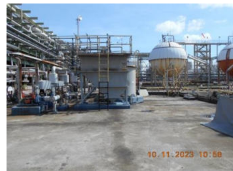
ภาพที่ 2.2-14 ระบบบำบัดน้ำเสียแบบ CPI ของโรงกลั่นน้ำมันหล่อลื่นพื้นฐาน (LBOP)
