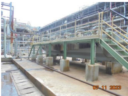
ภาพที่ 2.2-7 บ่อพักน้ำเสีย IAF หน่วย ADU
